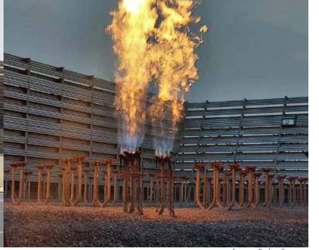
محرقه المواد الهيدروكربون
