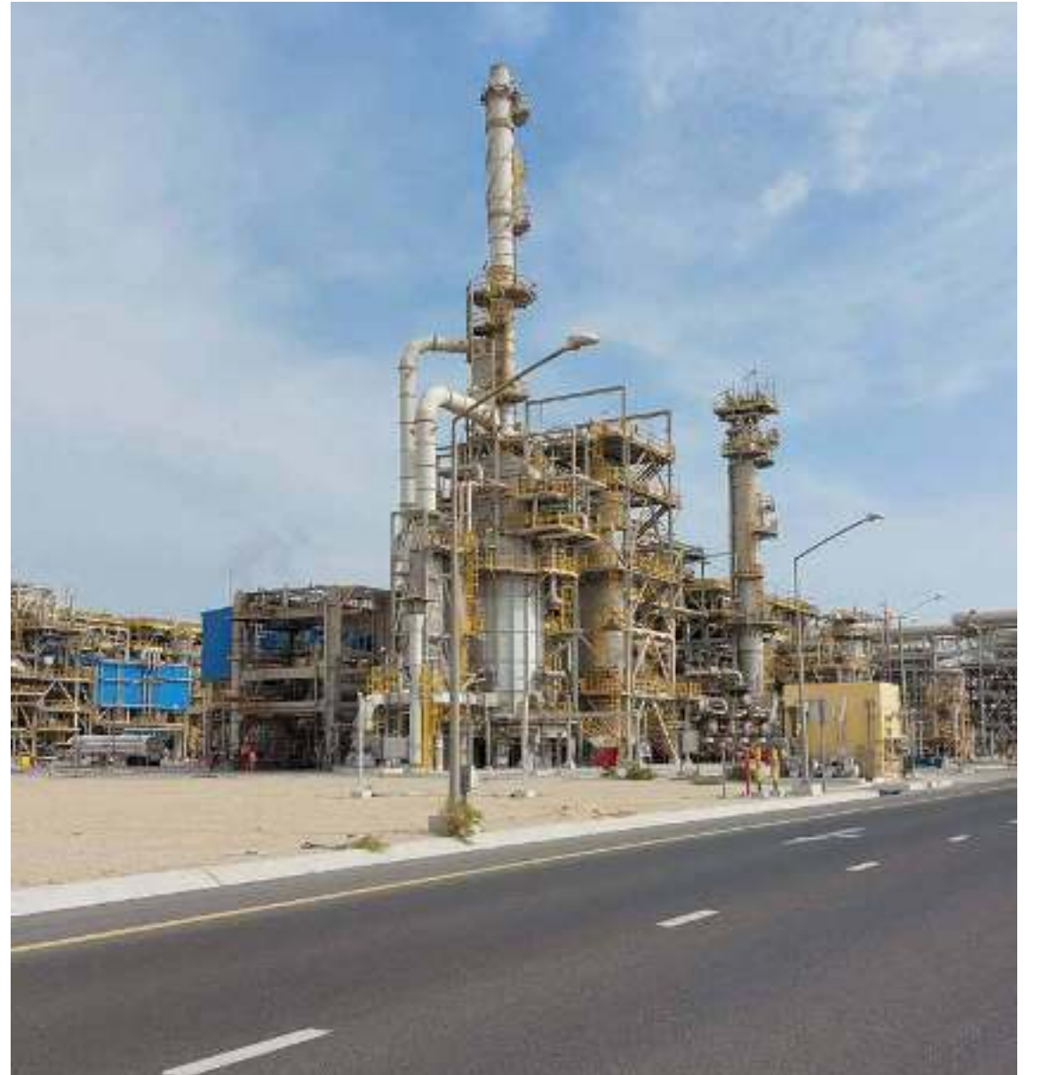
وحدة المعالجة الهيدروجينية للكبروسين (السخان الحراري KHT-05)
