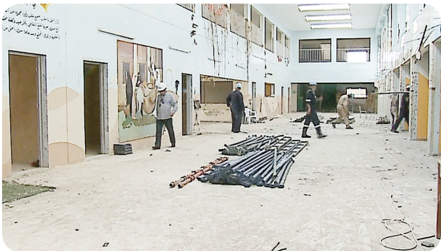
جانب من أعمال التجهيز في مبنى الزور 4
