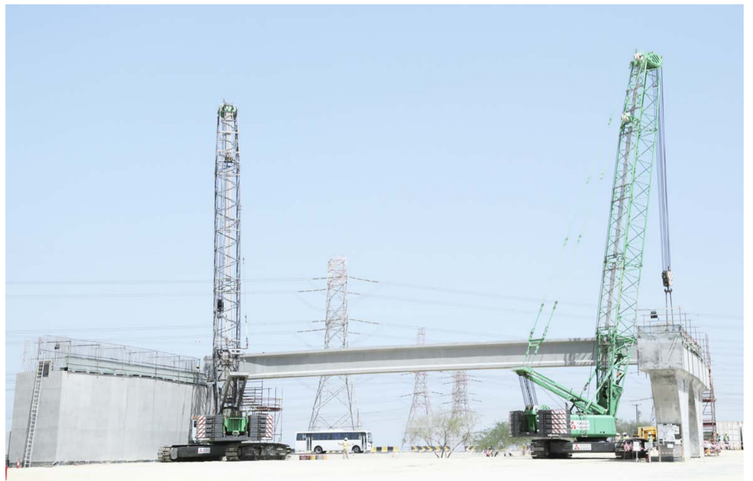
العارضة بعد عملية التركيب وتبدو الارتفاعات
