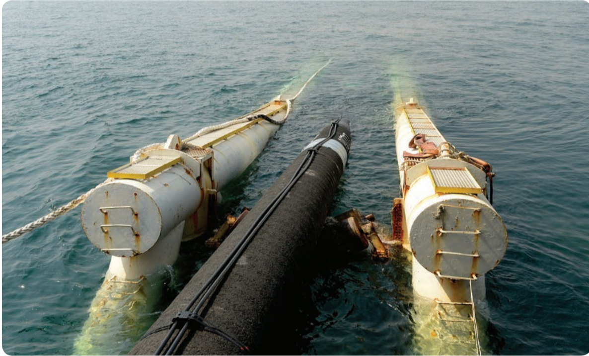
إنزال الأنابيب للمياه
